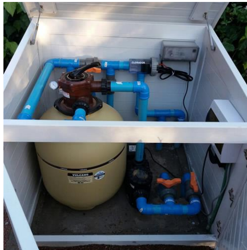
Figura 1. Bomba y filtro de PVC para circulación de agua [14].
