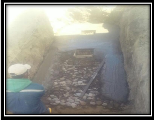
Fundición de Hormigón
