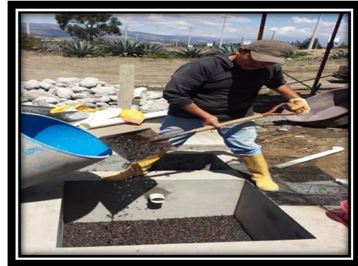
Colocación de Grava \frac{1}{2} Diámetro
