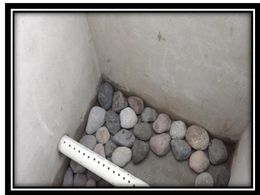
Colocación de Piedra Bola
