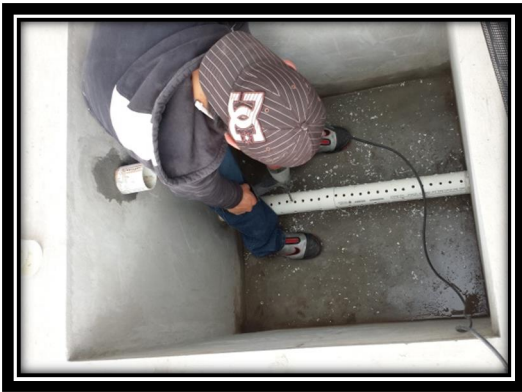
Perforación de Ingreso al Filtro
