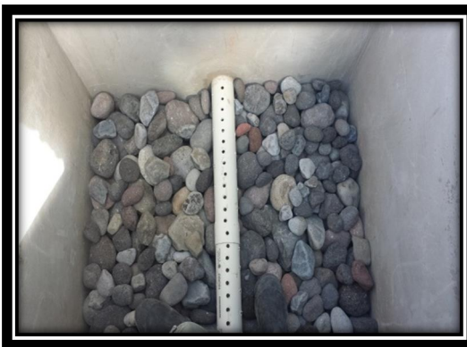
Colocación de Grava \frac{3}{4} Diámetro
