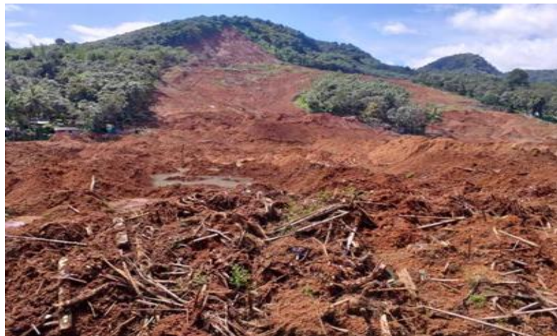
Figura 1 Deslizamiento de tierra [32].
