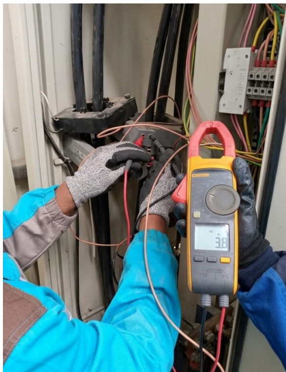
Figura I.3. Verificación del circuito secundario de los transformadores de corriente.
