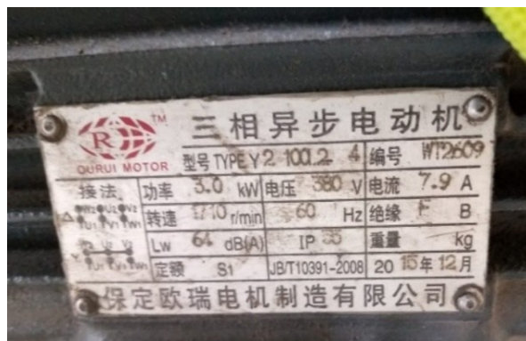
Figura F.2. Placa del motor de los extractores (M1- M8)
