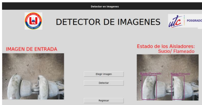
Figura 57. Detección aislador sucio/flameado.
