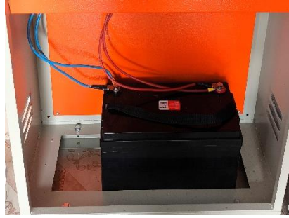
Figura 5.8 Conexión de la batería al sistema fotovoltaico
