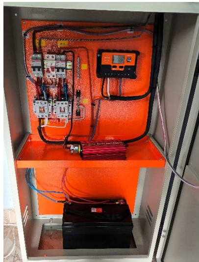
Figura 5.9 Conexión del inversor y sistema fotovoltaico
