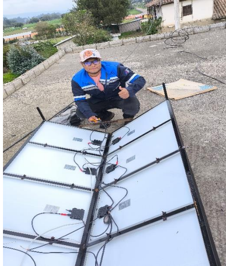
Figura 5.6 Conexión en paralelo de los paneles fotovoltaicos
