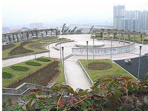
Figura.3. 4 Planta de tratamiento de agua potable. [23]
