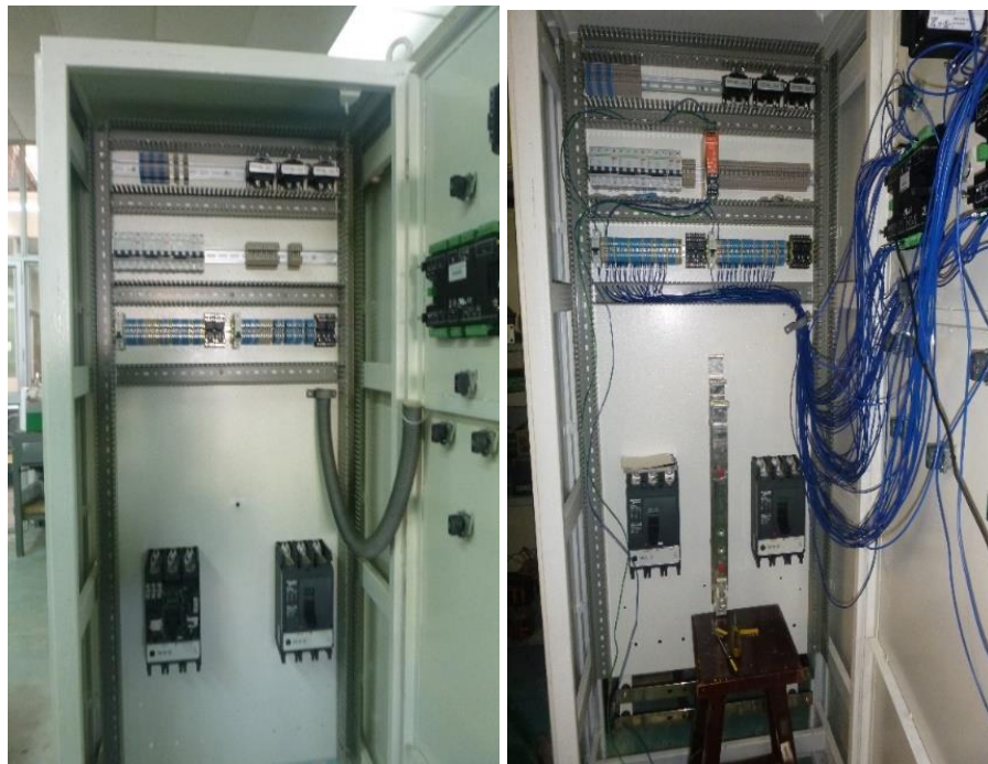
Figura 4. 7: Construcción tablero de transferencia (1)
