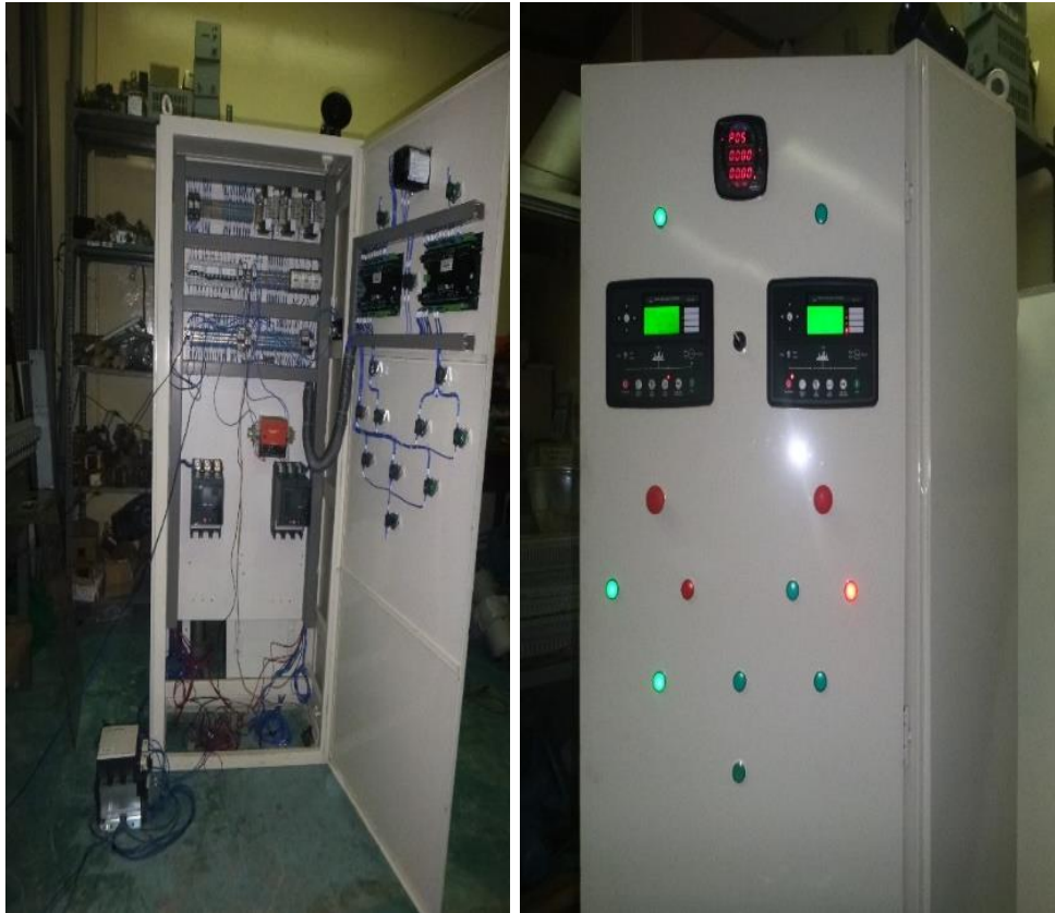
Figura 4. 8: Construcción tablero de transferencia (2) Fuente: EP Petroecuador (2016)
