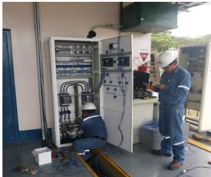
Figura 4. 35: Montaje e instalación tablero de transferencia nuevo
