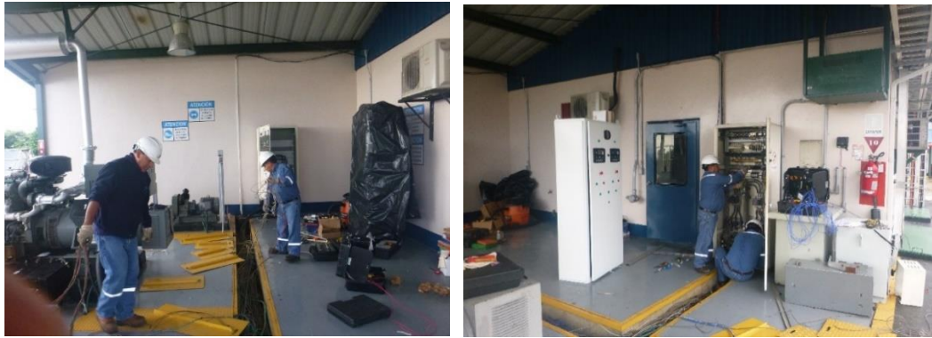
Figura 4. 34: Desmontaje tablero de transferencia antiguo
