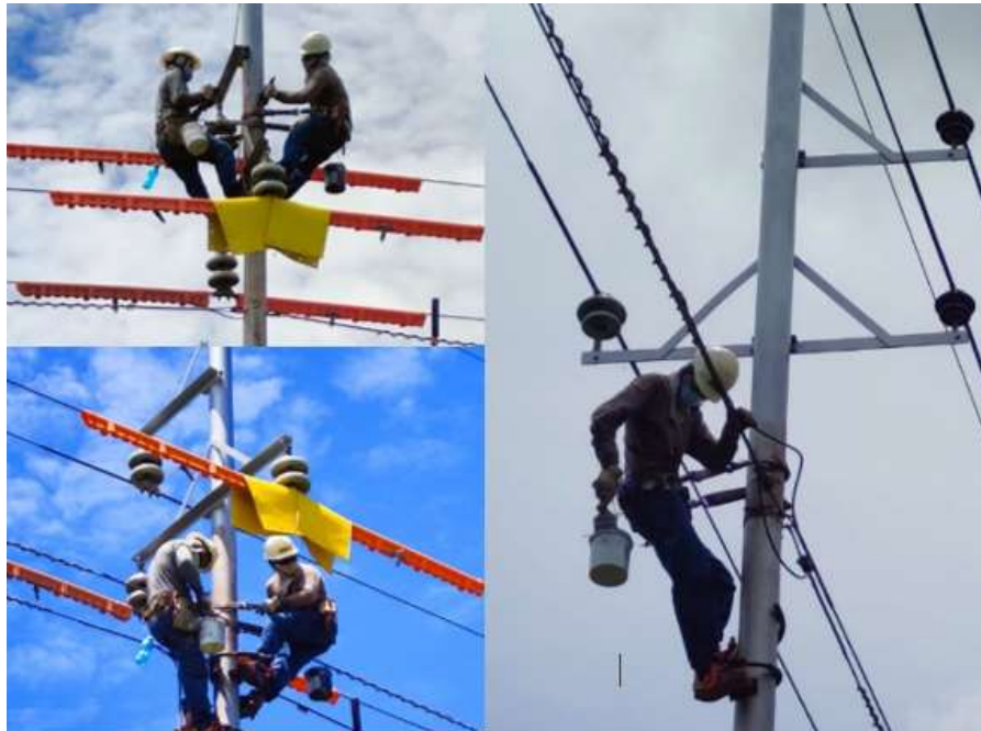
Imagen 12. PINTADO DE ESTRUCTURA A1 Y A2
