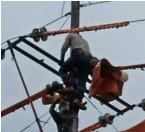
Imagen 19. ASCENSO A LA PARTE SUPERIOR DE LA CRUCETA.
