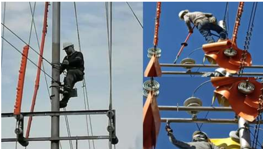
Imagen 23. PINTADO DE POSTE Y CRUCETA.
