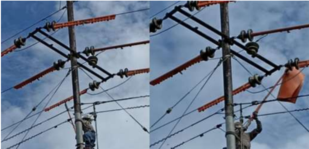
Imagen 17. COLOCACIÓN DE PROTECCIONES
