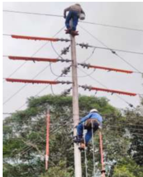
Imagen 15. REALICE LAS ACTIVIDADES GUARDANDO DISTANCIA DE SEGURIDAD ESTRUCTURA B3.
