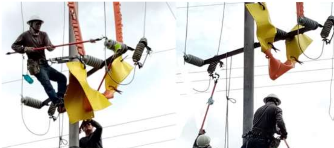
Imagen 22. LAVADO DE SECCIONADORES Y AISLADORES LINE-POST.
