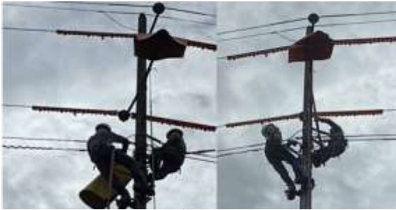
Imagen 9. COLOCACIÓN DE PROTECTORES EN ESTRUCTURA A1.
