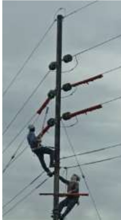
Imagen 13. COLOCACION DE PROTECCIONES CON PERTIGA ESTRUCTURA B2.
