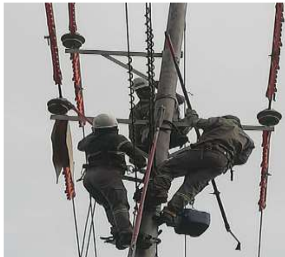
Imagen 11. LAVADO DE AISLADORES TIPO PIN
