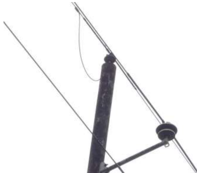
Fig. 10. Estructura A1 con lazo de aterrizamiento de puesta a tierra
