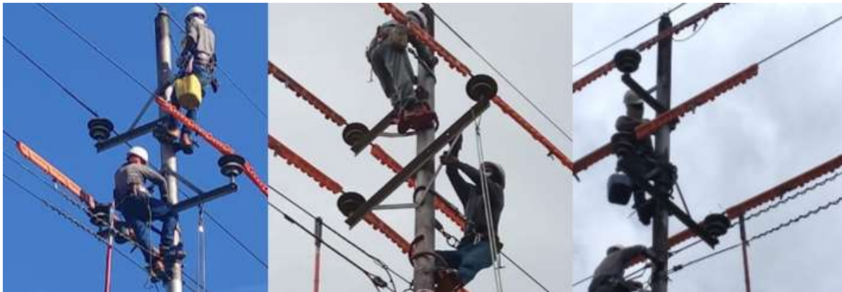
Imagen 10. LIJADO DE ESTRUCTURA A1
