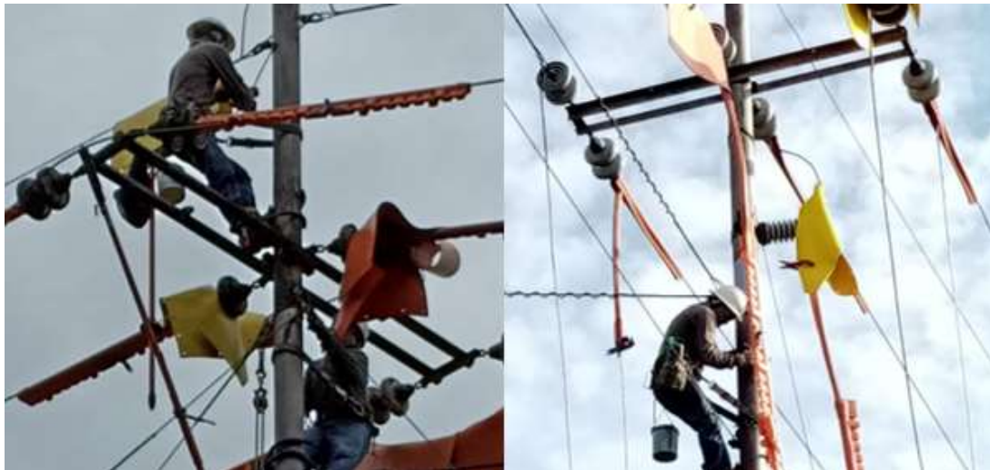
Imagen 20. LIJADO DE POSTE Y CRUCETA METALICA.
