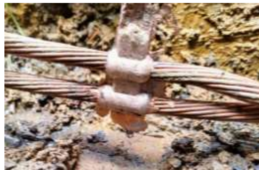
Imagen 4. SUELDA CABLE-CABLE
