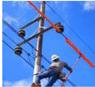
Imagen 8. COLOCACION DE PROTECTORES EN ESTRUCTURA A2.
