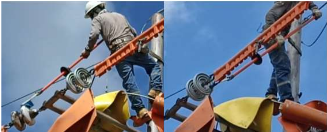
Imagen 21. LAVADO DE AISLADORES SE SUSPENSION.
