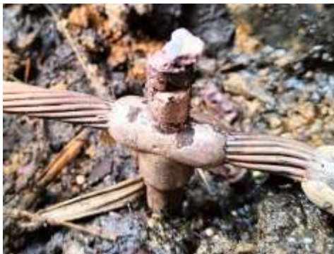
Imagen 5. SUELDA CABLE-VARILLA
