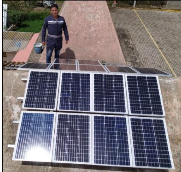
Figura 35. Culminación de la colocación de paneles solares.
