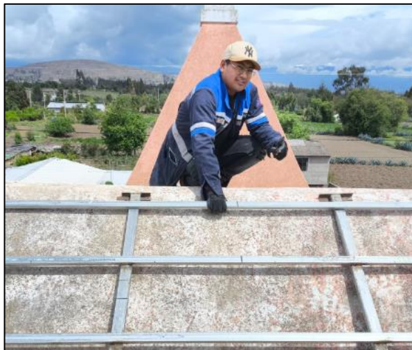
Figura 30. Ubicación de las estructuras metálicas.
