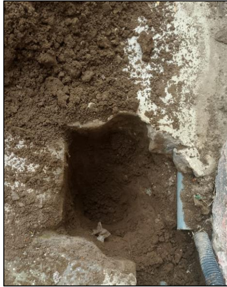
Figura 42. Reconocimiento del lugar para el SPT.
