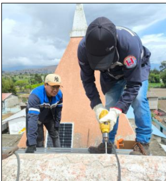
Figura 31. Perforación para empotrar la estructura.
