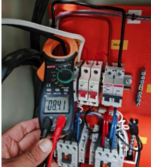
Figura 49. Medición de corriente en la red eléctrica.
