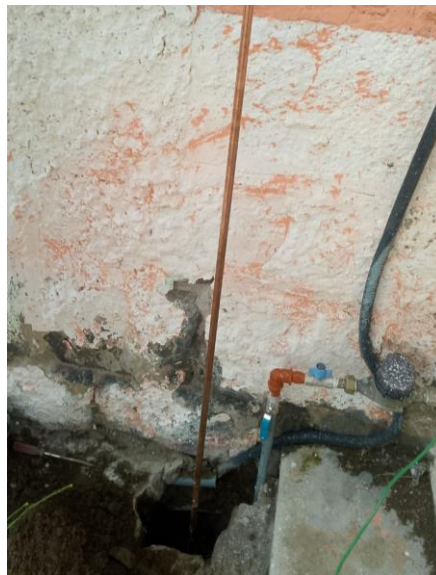
Figura 43. Ubicación de la varilla copperweld.
