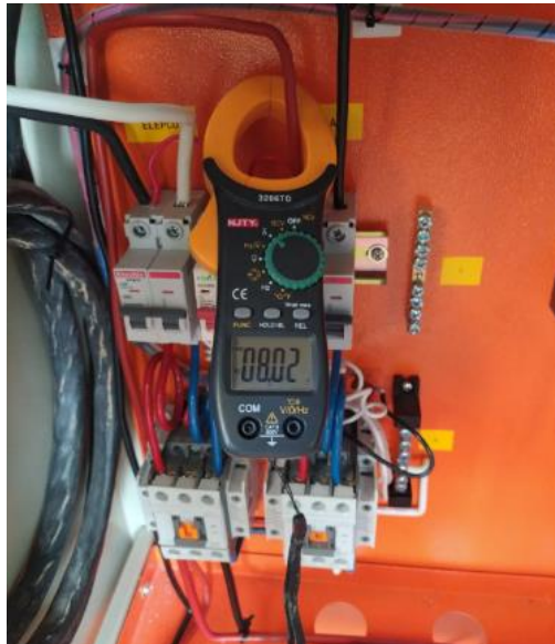
Figura 50. Medición en el sistema fotovoltaico.
